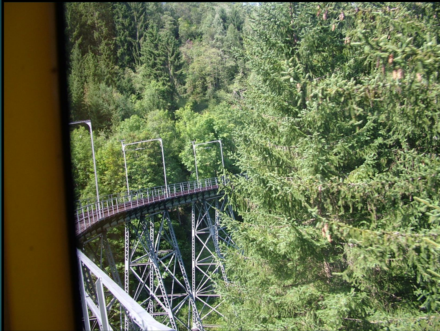
Viadotto di Kreitle costruito con sistema Trestle (dal tram)
