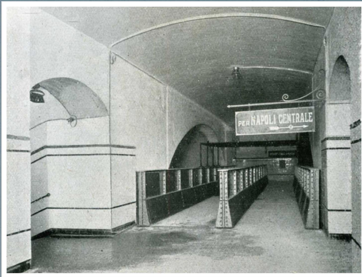
Piazza Amedeo: la passerella pedonale in ferro con pavimentazione in legno per l'attraversamento dei binari.
