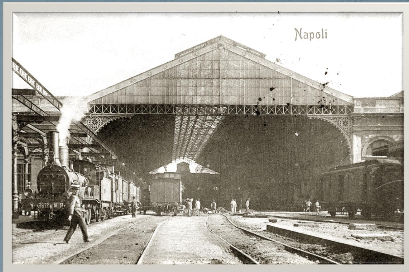
Stazione di Napoli Centrale: la tettoia in ferro e vetro del Cottrau ed il piazzale binari visti prima dello scavo del trincerone; e ...
