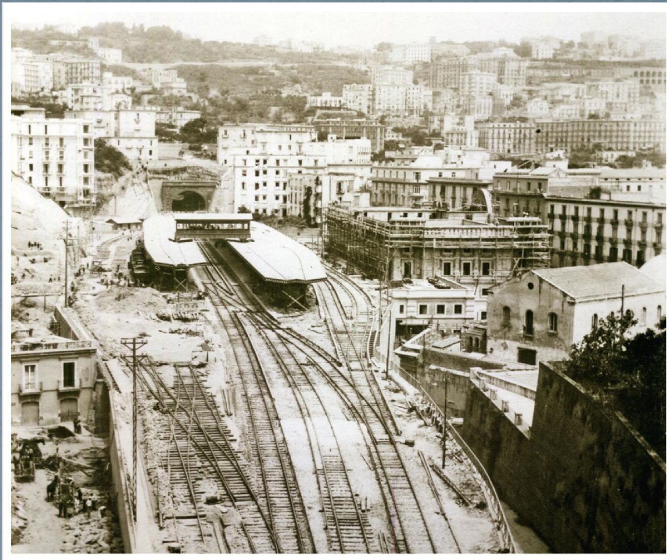
Ancora la stazione di Chiaja in costruzione.
