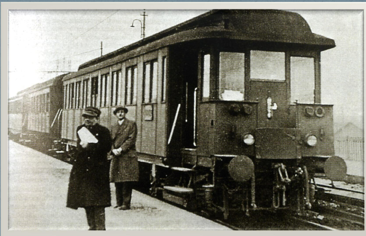
Elettromotrice a comando multiplo del tipo E.20 Questi rotabili provenivano dalla linea Varesina.
