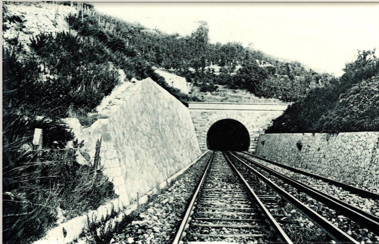
Imbocco lato Roma della galleria dei Campi Flegrei, lunga m 1772,97.
