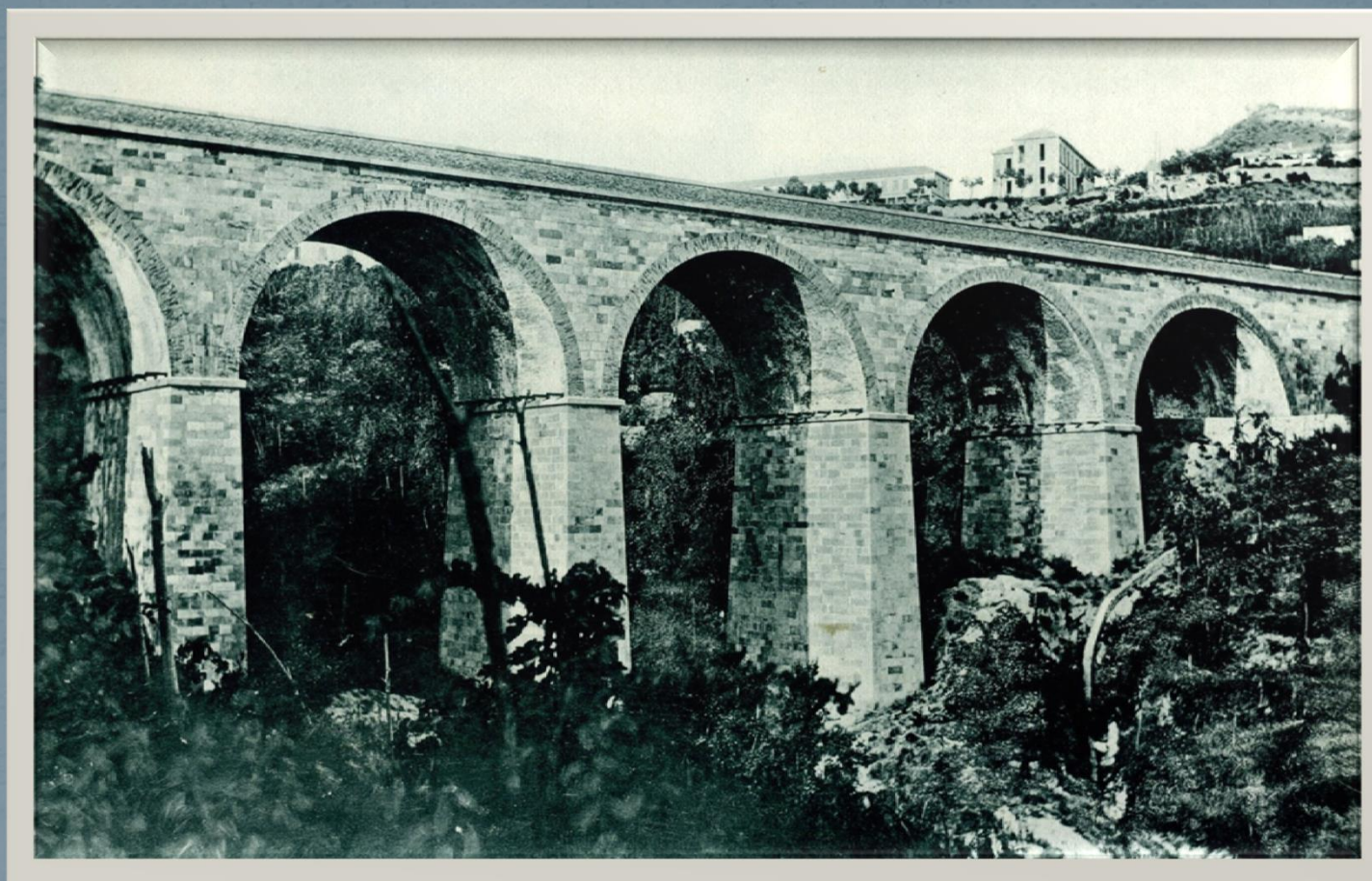
Viadotto sul 'Vallone Filangieri' a sei archi, ciascuno di m 14 di luce.
