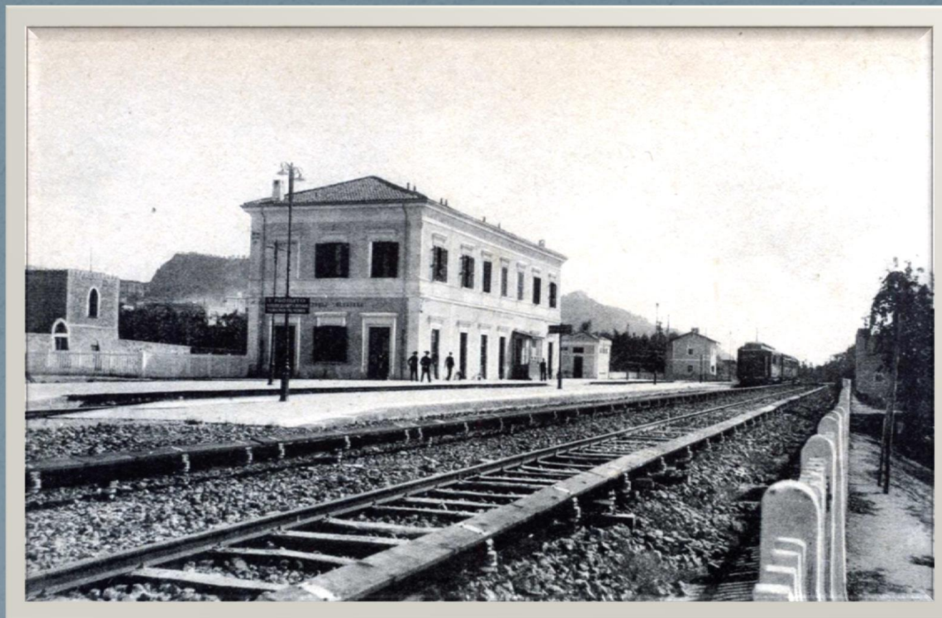
Pozzuoli – Solfatara: il fabbricato della stazione con in sosta un convoglio sul primo binario. È ben visibile la protezione in legno della terza rotaia.
