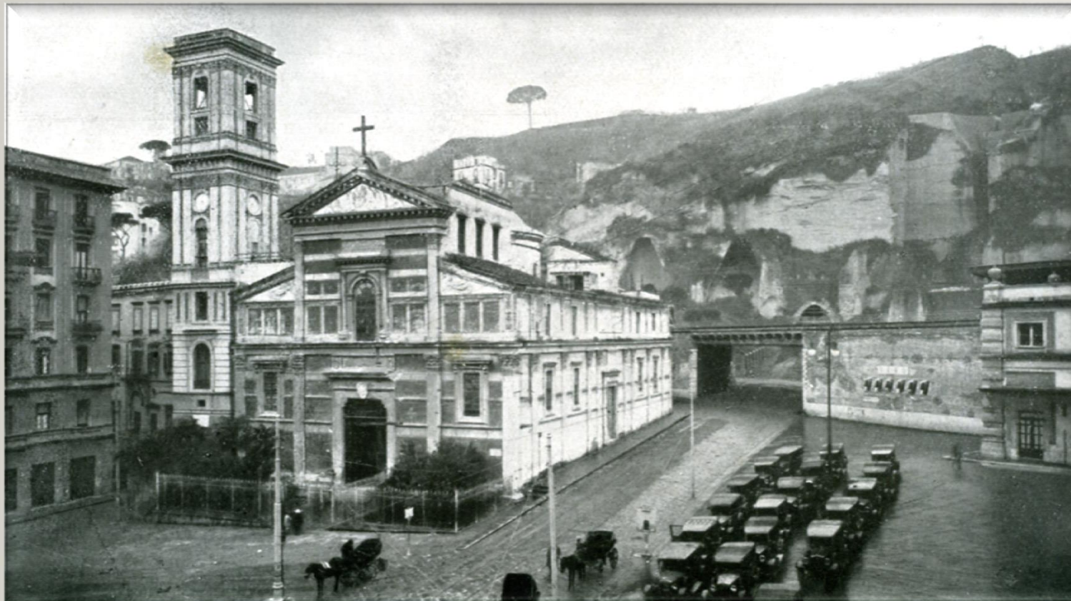
Panoramica della Chiesa di Piedigrotta, con sul fondo il Ponte della Linea Napoli - Pozzuoli.
