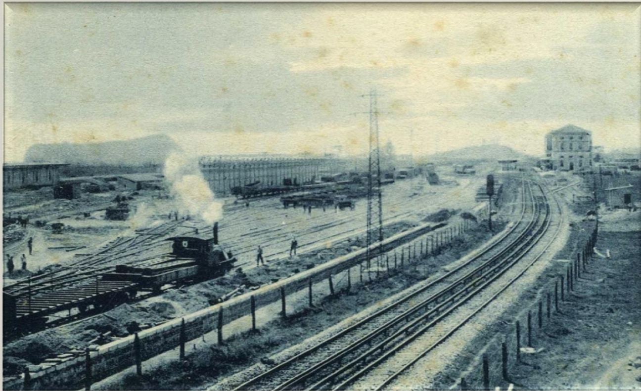
In arrivo alla stazione di Campi Flegrei. Una locomotiva a vapore in manovra nell'ampio Scalo Merci.
