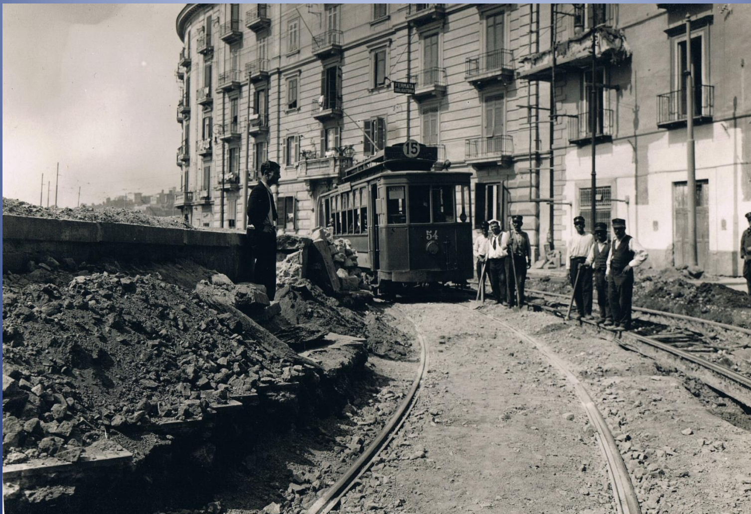
Motrice di tipo «Charleroi» modificata con l'adozione di motori GE 57 e rinumerata 54 (già 565).
