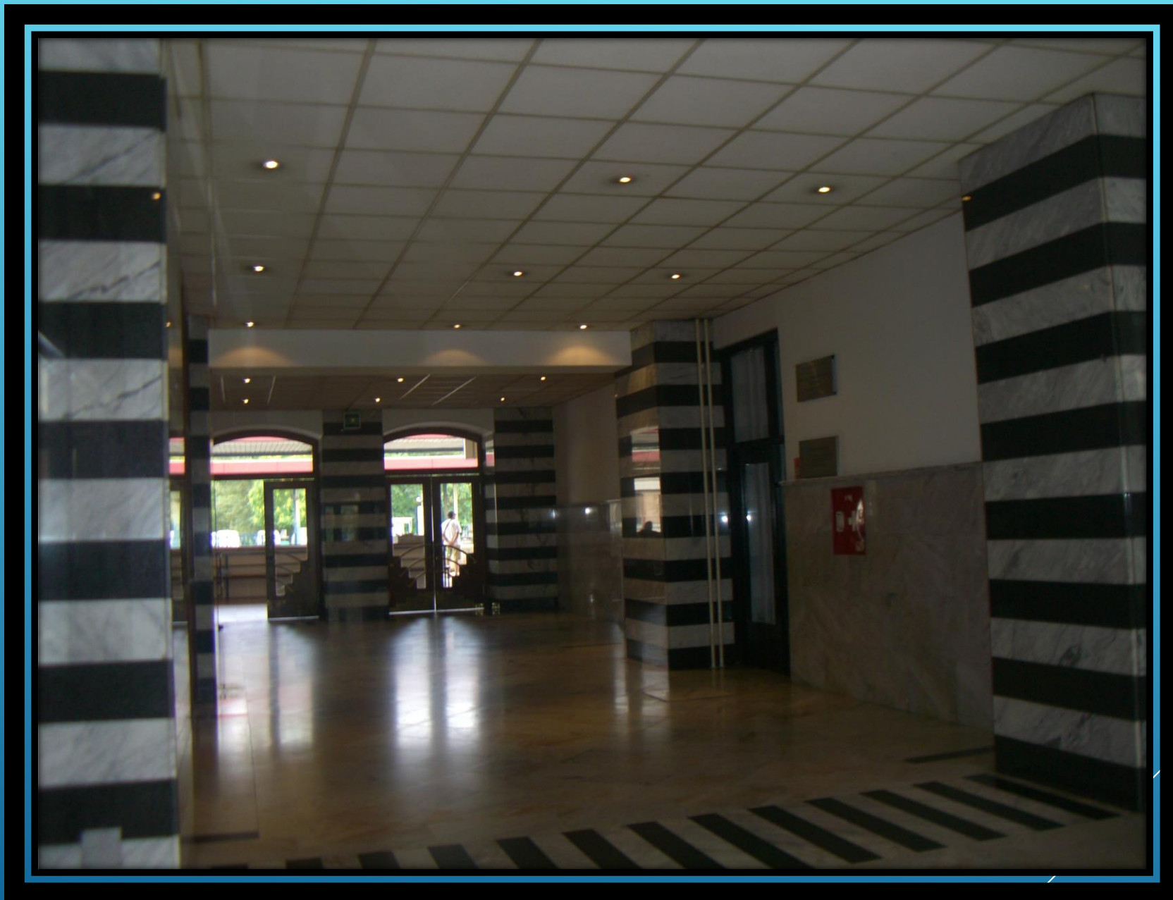
Stazione di Celje: la sala che dall'esterno conduce ai binari
